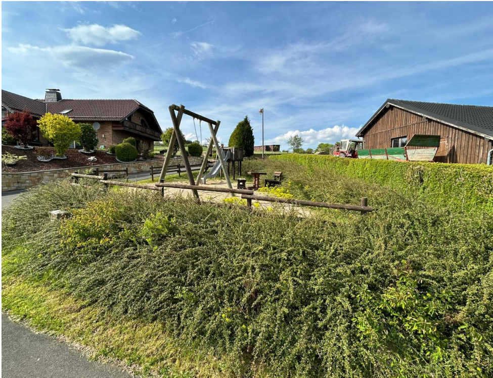
Abbildung 4: Ansicht von Süden nach Norden
