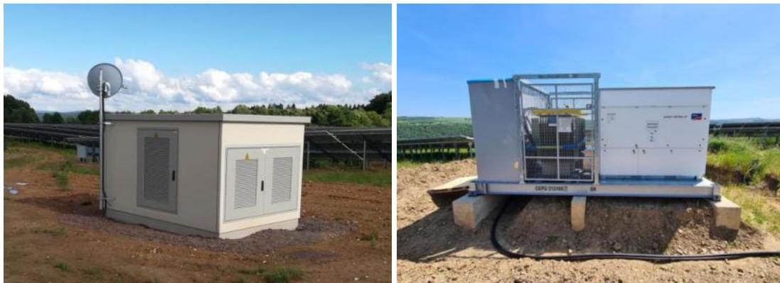
Abbildung 3: Beispielhafte Trafostation als Kompaktstation auf einer Freiflächenlage (links) und Kombistation mit Trafo, Wechselrichter und Schaltanlage auf einem Streifenfundament (rechts)
