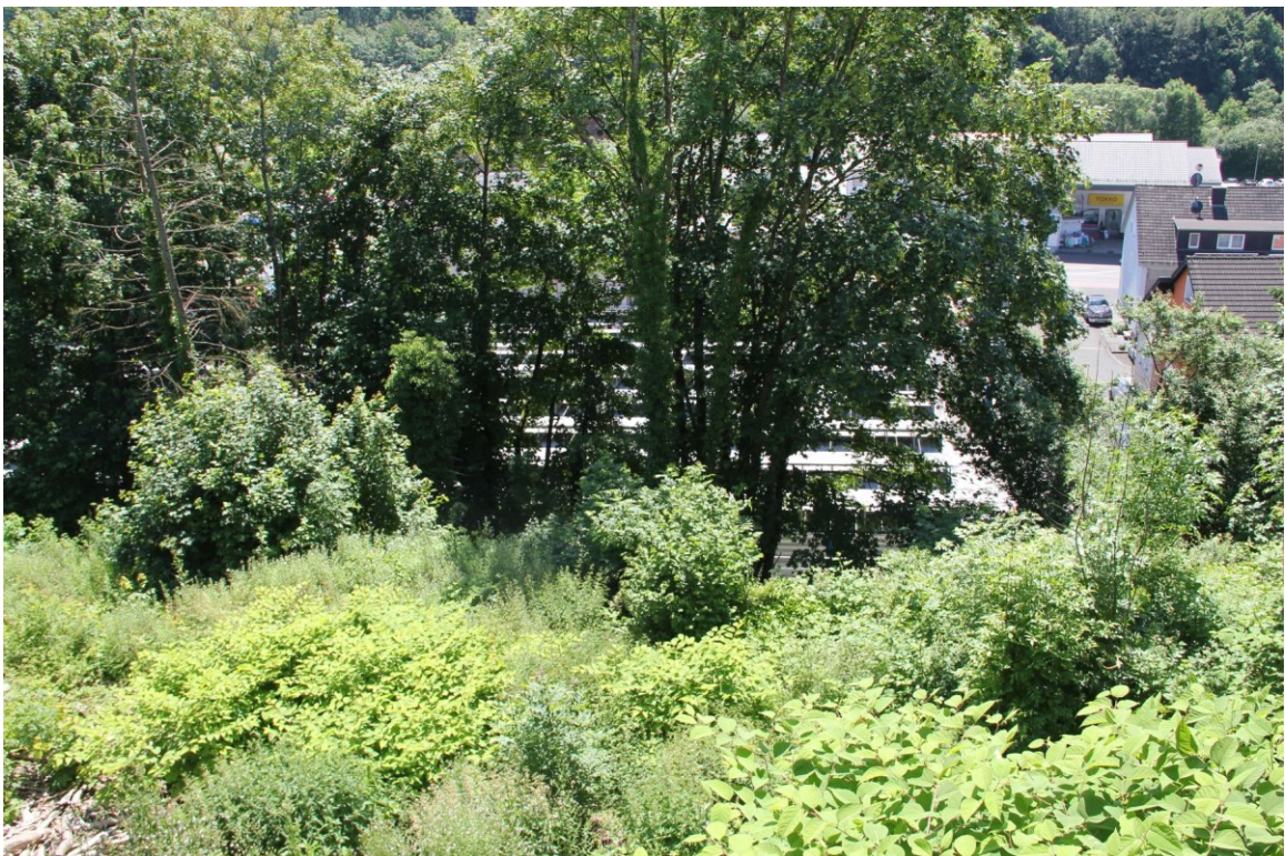
Böschung oberhalb des Grundstücks
