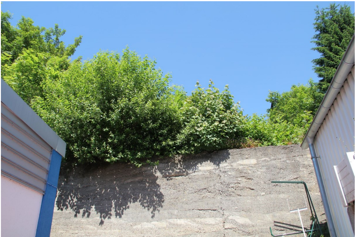
Rückwärtiger Bereich mit Stützmauer und Böschungsgehölzen
