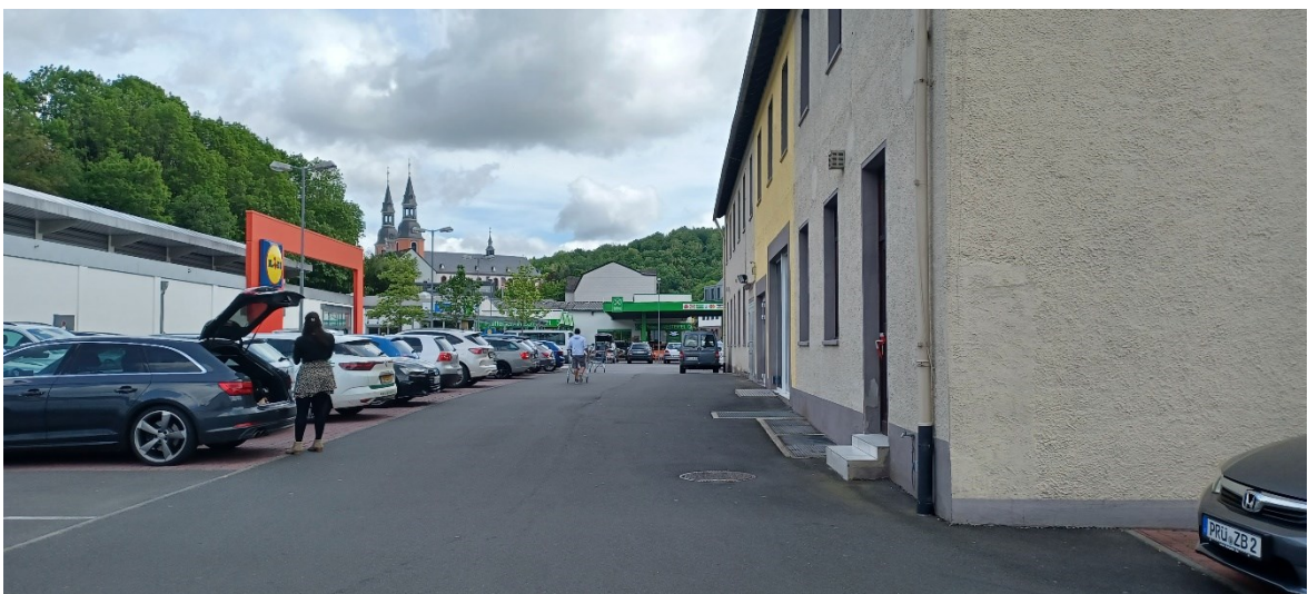
Blick von Westen in die Fläche, links der Kaufmarkt, rechts das abzureißende Postgebäude
