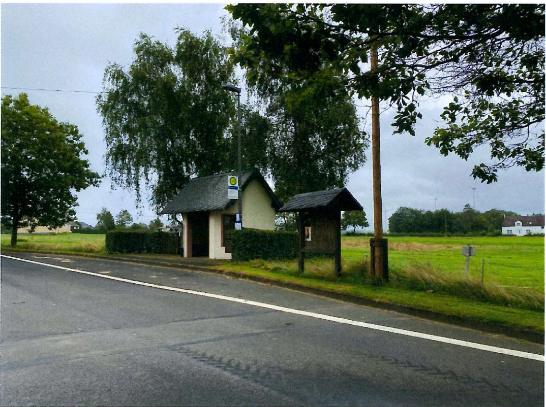
Foto 2 Blick auf Buswartehalte gegen Osten
