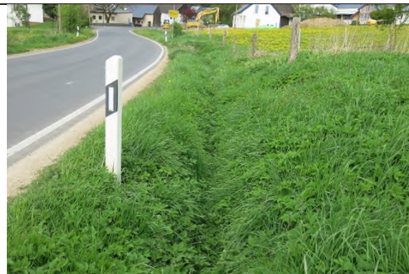
Foto 5: Entwässerungsgraben nördlich der Landesstraße L 16
