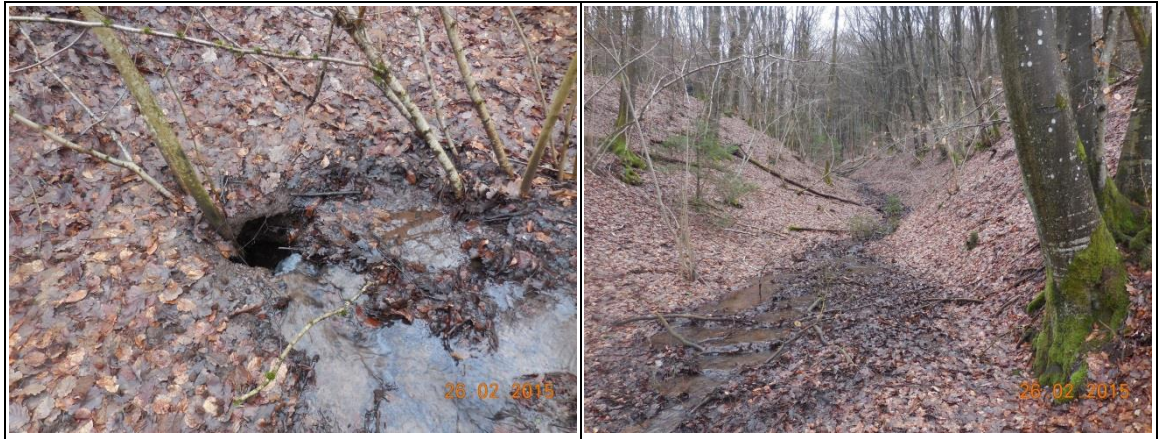
Abb. 30: Foto des künstlichen Durchlasses im Süden (links) und Pittenbachzufluss oberhalb des Durchlasses (rechts).
