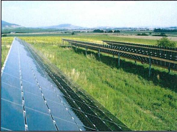
Beispiel für eine aufgeständerte Anlage mit Unterwuchs
