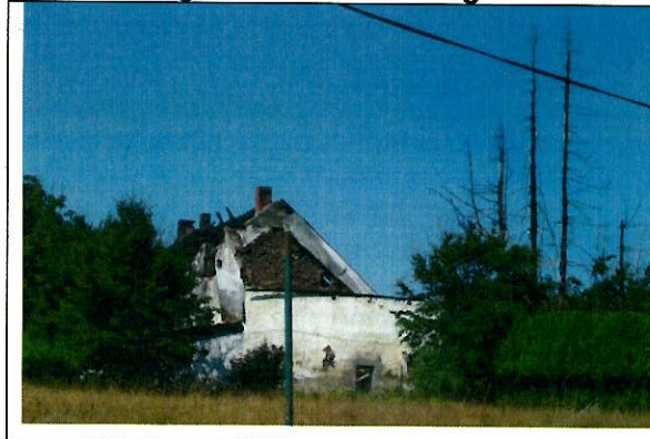
Foto 3: Angrenzende Bebauung - Ruine
