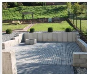
Auw a.d. Kyll – Errichtung eines Grillplatzes am DGH
