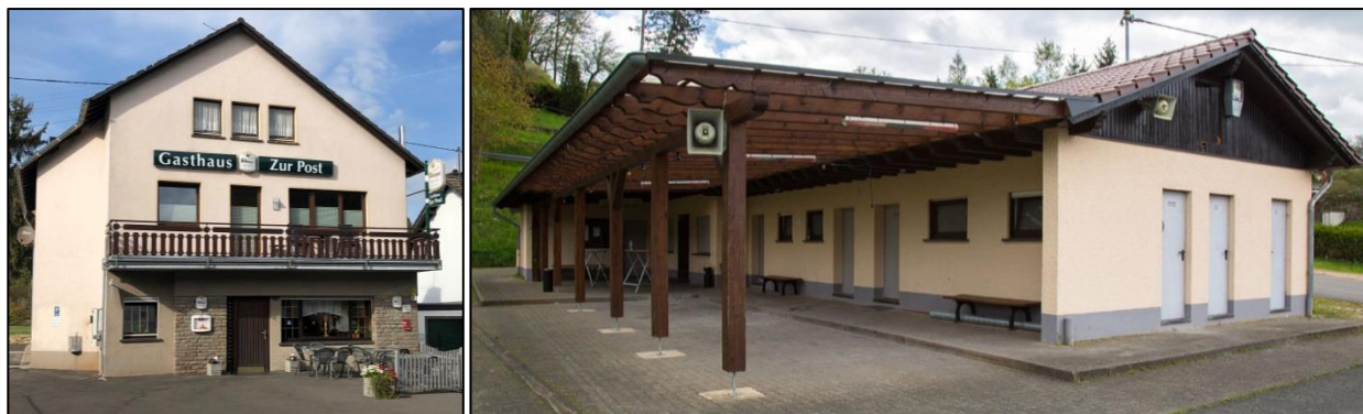
Das Sportplatzgebäude verfügt bereits seit dem Sportfest 2018 über öffentliches WLAN
