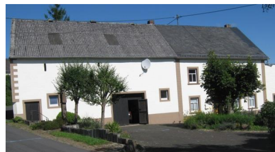
Gut erhaltenes Gebäude in der Hauptstraße
