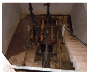
Innenansicht vom Pumpenhaus
