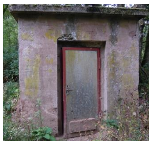
Außenansicht vom Pumpenhaus
