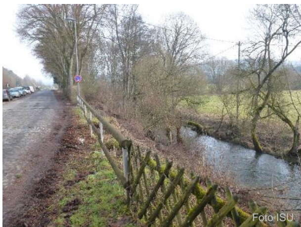
Abbildung 60: Prüm im Bereich der Bahnhofstraße
