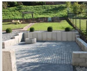
Auw a.d. Kyll – Errichtung eines Grillplatzes am DGH
