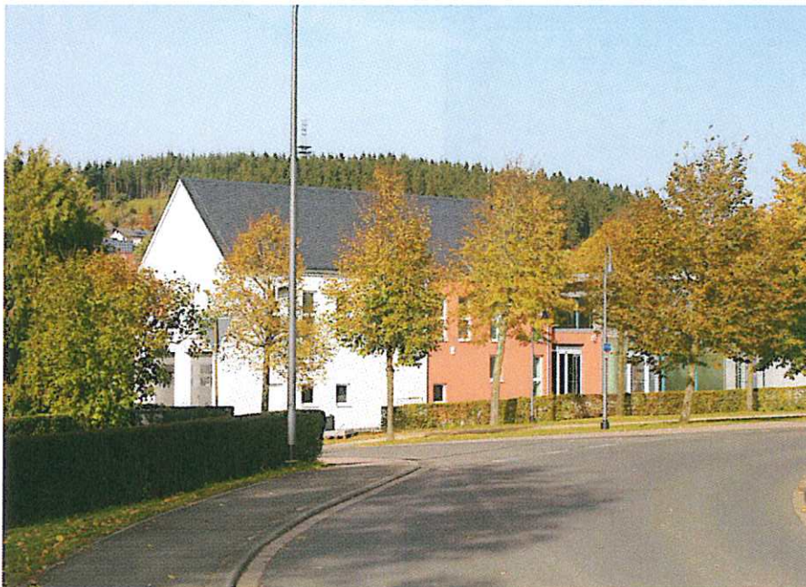
Foto: Neues Bürgerhaus mit Feuerwehrgerätehaus
