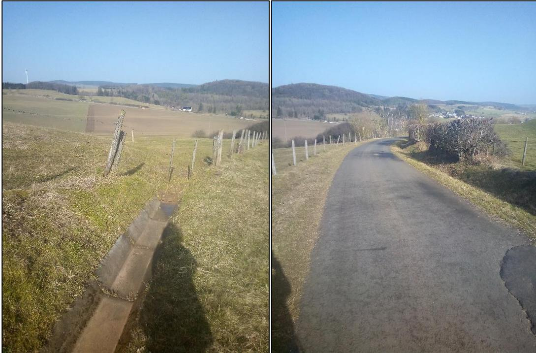
Abbildung 45: Pilgerweg, links: Graben mit Halbschalen, rechts: Blick in Richtung Ortslage
