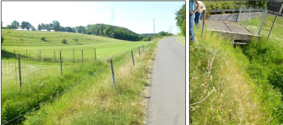
Abbildung 54: Entwässerungsgraben der Tiefenlinie mit Durchlass und Einlauf für Straßenquerung und Zufahrt
