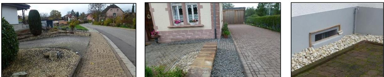
Abbildung 31: Beispiele von Objektschutzmaßnahmen (Überbogen, Geländemodellierungen, Aufkantung am Kellerfenster)
