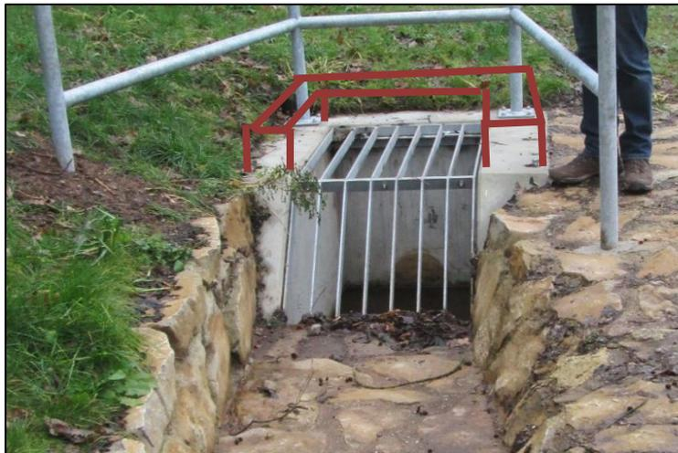
Abbildung 48: Beispiel eines hydraulisch günstigen Einlaufbauwerkes mit einskizzierter Aufkantung
