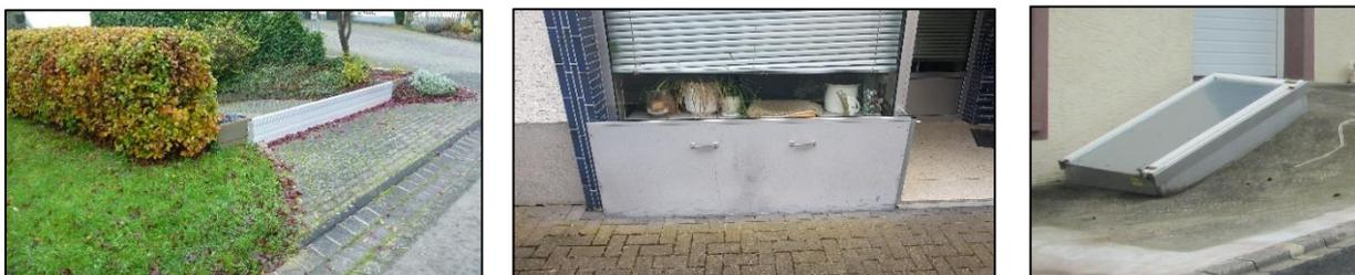
Abbildung 30: Beispiele von Objektschutzmaßnahmen (mobile Steckelemente, Dammbalkensysteme, Abdichtungen)
