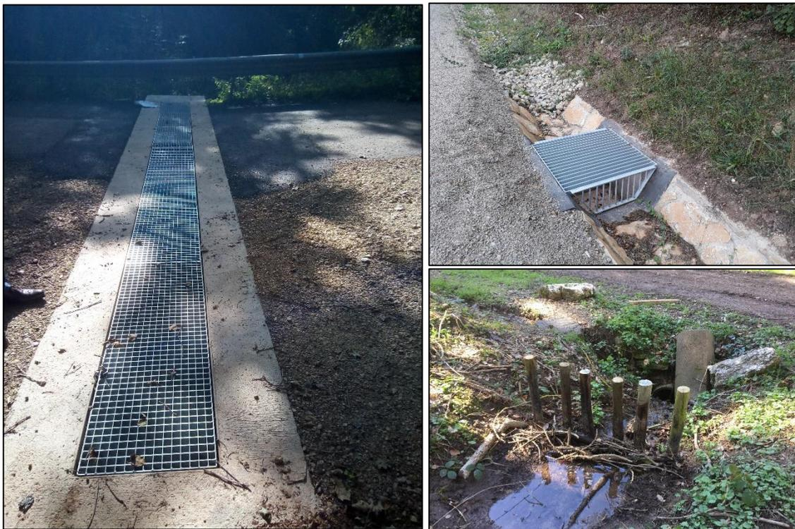
Abbildung 41: Möglichkeiten der Querung eines Weges durch überfahrbare Rinne (links) oder Verrohrung mit zweidimensionalem Einlaufbauwerk mit Rechen und Grobrechen (rechts)
