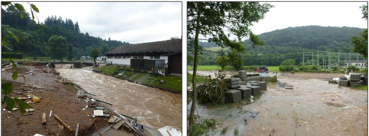
Abbildung 2.3: Schäden durch Überflutung der Prüm (Eigenes Bild, 2021)
