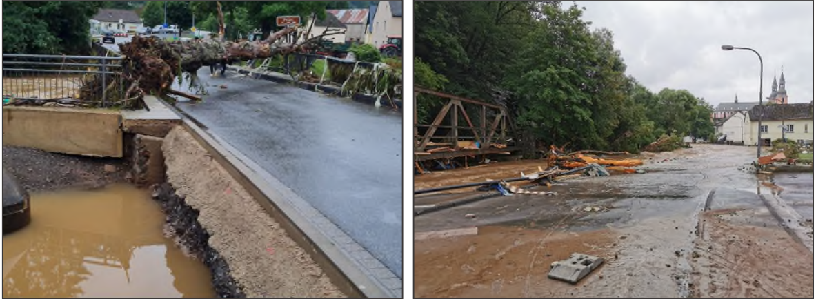
Abbildung 2.2: Zerstörungen an der Infrastruktur (Eigenes Bild, 2021)
