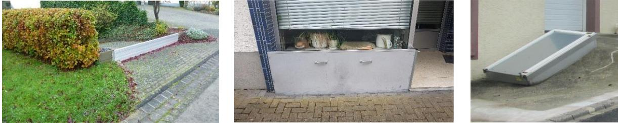
Abbildung 33: Beispiele von Objektschutzmaßnahmen (mobile Steckelemente, Dammbalkensysteme, Abdichtungen)
