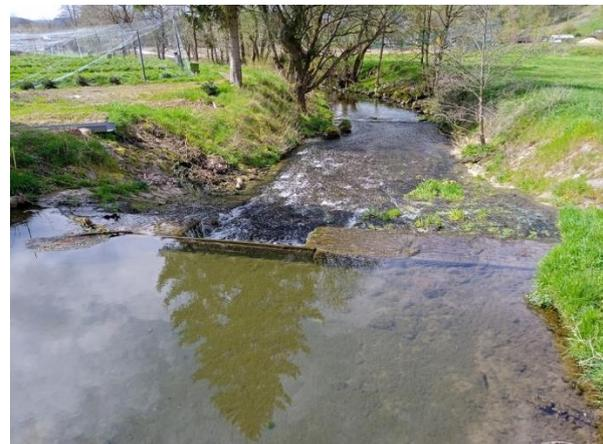
Abbildung 55: Nimswehr ohne funktionierende Regulierungsmöglichkeit
