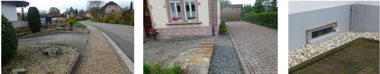
Abbildung 34: Beispiele von Objektschutzmaßnahmen (Überbogen, Geländemodellierungen, Aufkantung am Kellerfenster)
