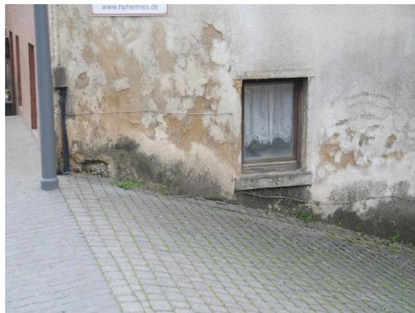
Abbildung 111: feuchte Wände in der Hausnr. 43
