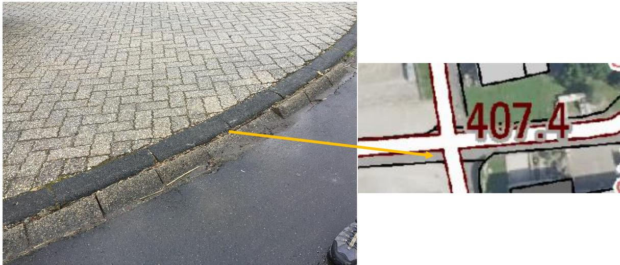
Abbildung 93: Verschobene Bordsteine aufgrund vergangener Überflutungen in der Hühnerbachstr. 18
