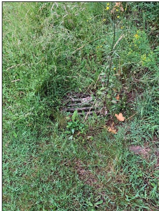
Abbildung 33: Einlaufbauwerk in die Ortskanalisation vor der Kreuzung „Im Spang“
