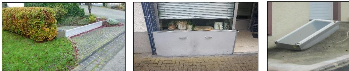
Abbildung 23: Beispiele von Objektschutzmaßnahmen (mobile Steckelemente, Dammbalkensysteme, Abdichtungen)
