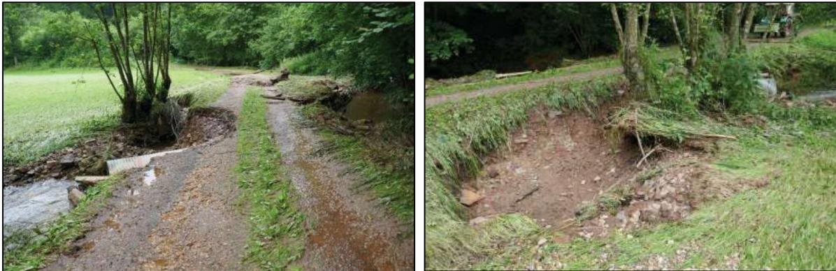
Abbildung 65: beschädigter Durchlass am Dürrbach nach Starkregen Juli 2021
