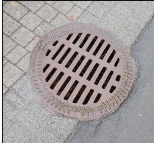
Abbildung 39: Beispielfoto eines als Einlaufrost ausgeführten Schachtdeckels einer Bachverrohrung
