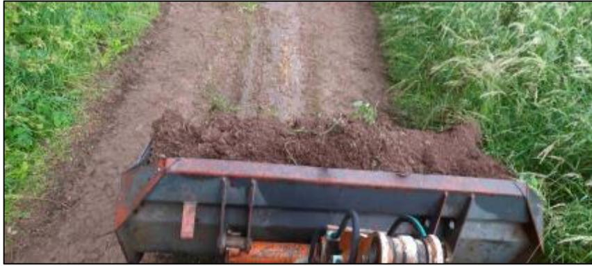
Abbildung 64: Abtransport der erodierten Erdmassen
