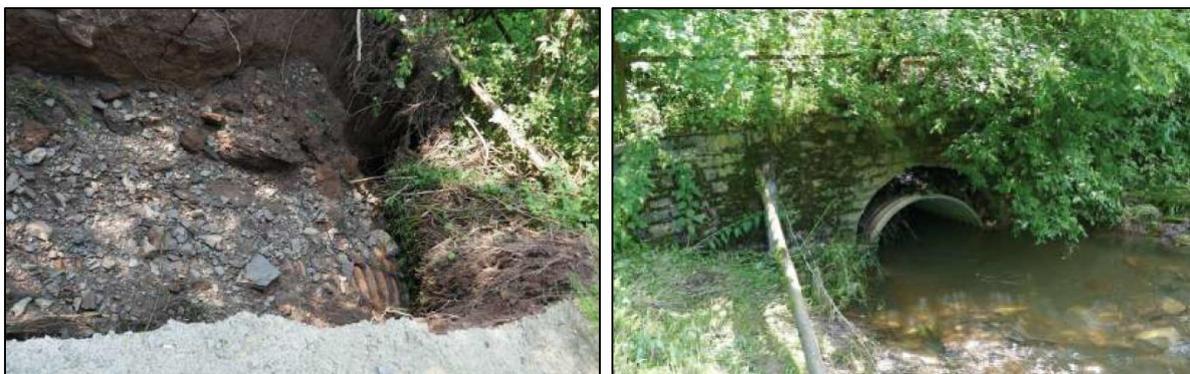
Abbildung 50: Hochwasserschäden am Brückendurchlass am Johannesbach
