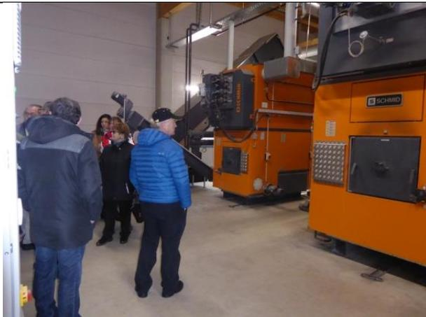
Heizzentrale mit den beiden Hackschnitzelkesseln.
